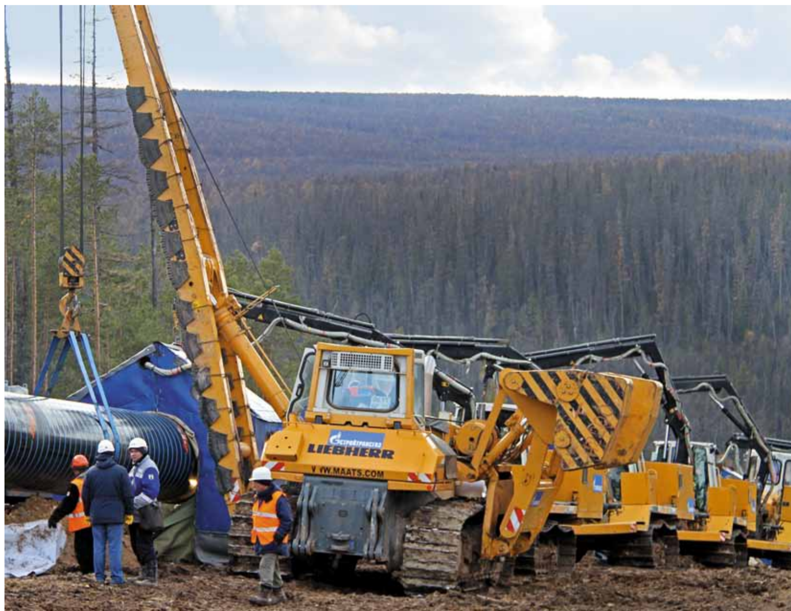
Строительство газотранспортной системы «Сила Сибири» ведется в соответствии с графиком
