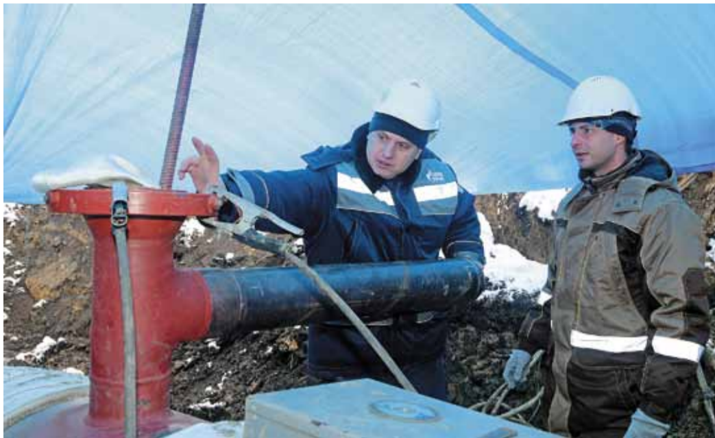
На газопроводе Юрга – Новосибирск врезку под давлением проводили впервые
