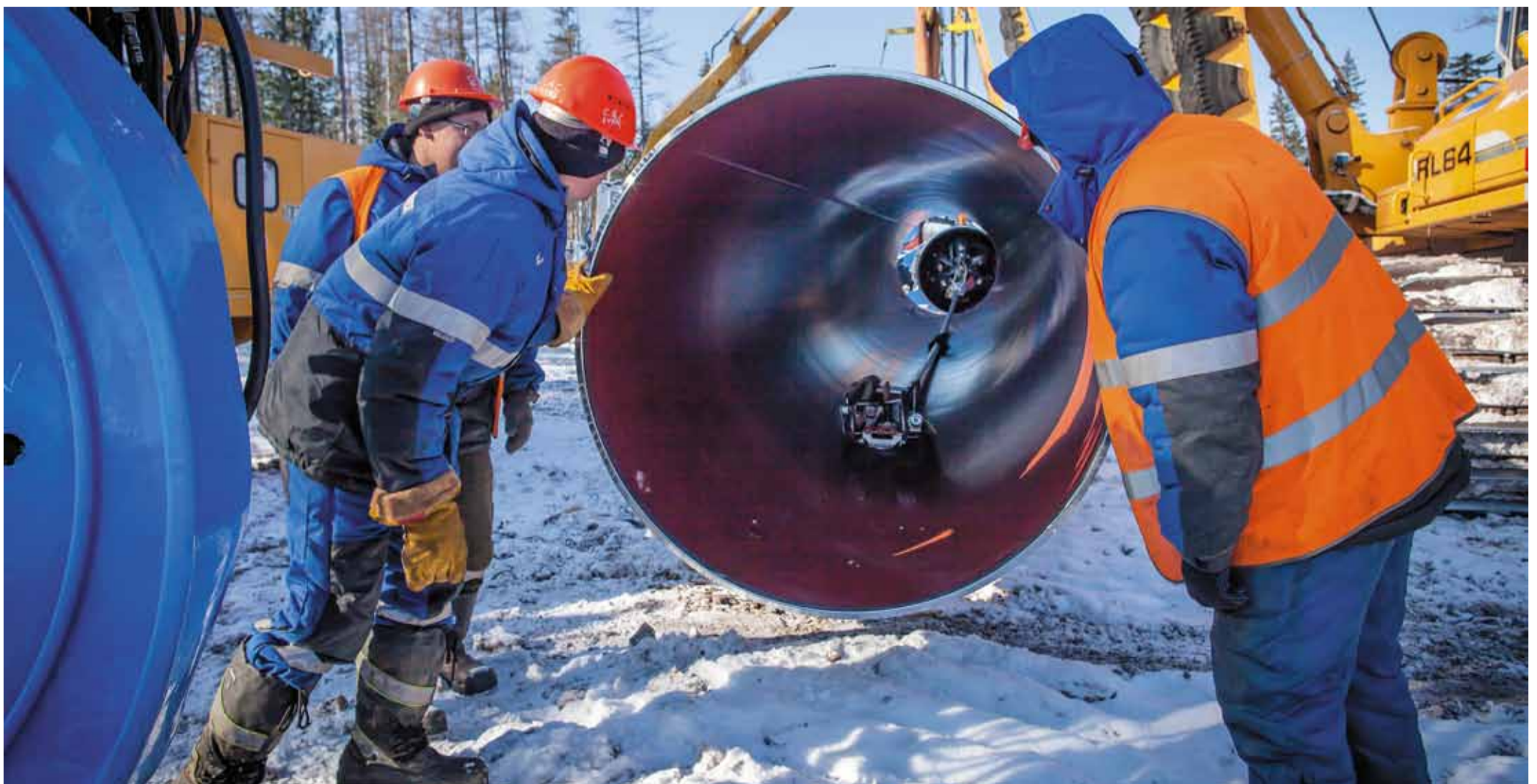
При строительстве магистрального газопровода «Сила Сибири» применяются самые современные сварочные технологии
